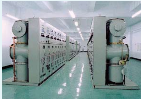
23 ~161 kV GIS 設備
