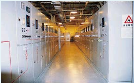
高低壓配電盤
