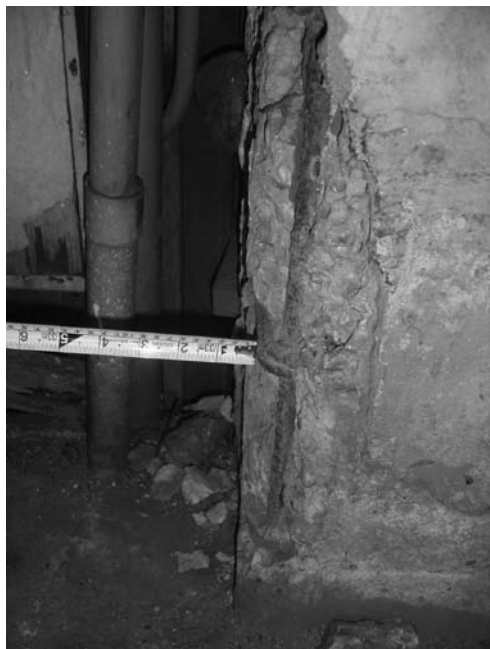
照片1 RC柱表面混凝土及1：3水泥粉刷層剝落
