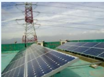
太陽能發電統包工程
