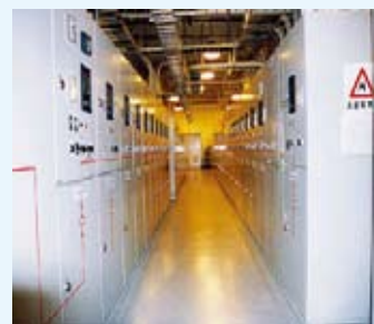
高低壓配電盤
