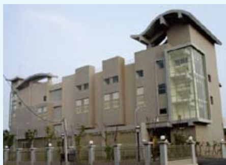
台電變電所統包工程
