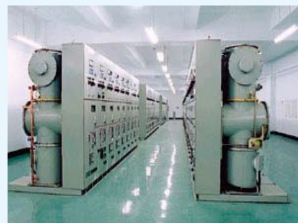
23 ~161 kV GIS 設備
