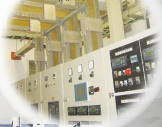
模鑄式匯流排 1000V (含) 以下500A-5000A
